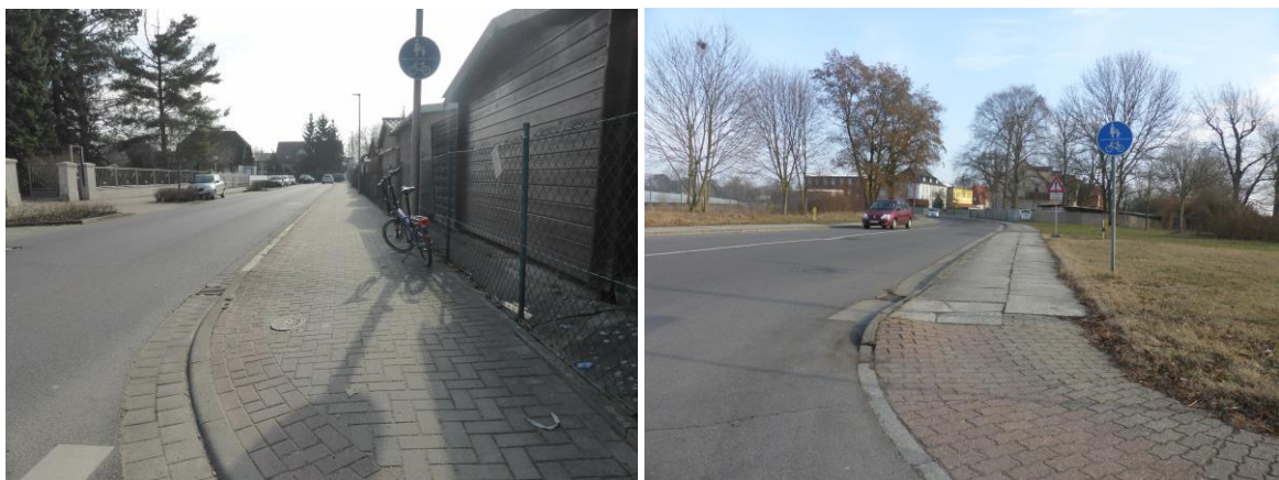
Charlottenstraße (links) und C.-A.-Groeschke-Straße (rechts) mit Benutzungspflicht der Nebenanlage
