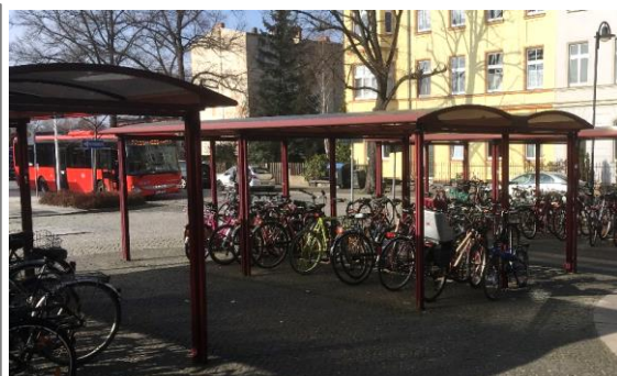
Überdachte Radabstellanlage am Bahnhof Forst (Lausitz)
