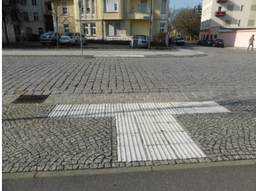
Taktile Elemente vor Querung am Knotenpunkt Kegeldamm / Max-Fritz-Hammer-Straße
