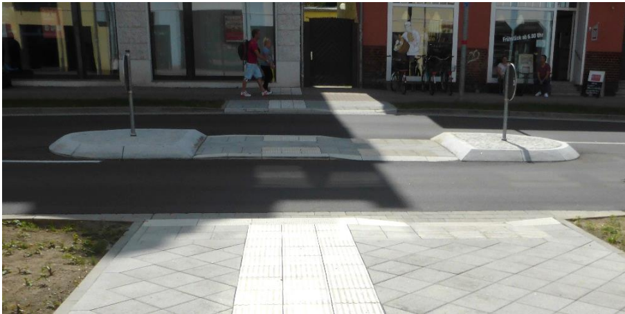
Querungsanlage auf der Cottbuser Straße (Beispiel)
