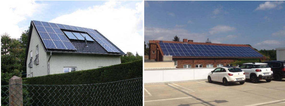
Abb. 18: private Solaranlage Carl-August-Groeschke-Straße sowie Promenade 20
