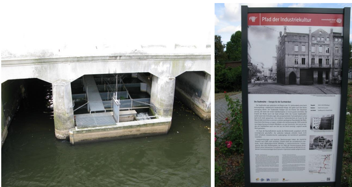
Abb. 19: Wasserkraftanlage in der Mühlenstraße am Mühlengraben
