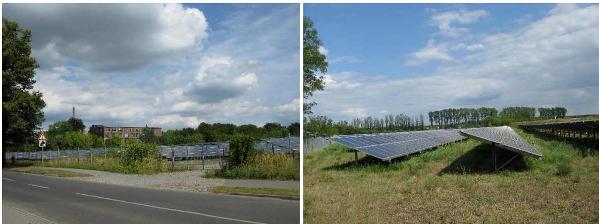
Abb. 17: Solaranlagen Solarpark Badestraße und Gewerbegebiet Süd
