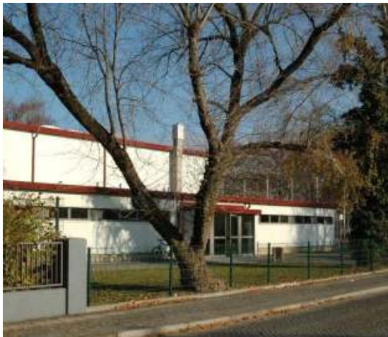
Sanierte Turnhalle an der Sorauer Straße
