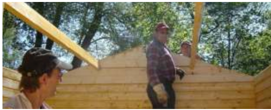
Kanustation, Errichtung in Selbsthilfe
